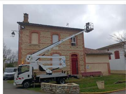
Nettoyage des gouttières
