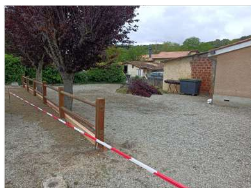
Aménagement du parking du « Petit Vernet »
