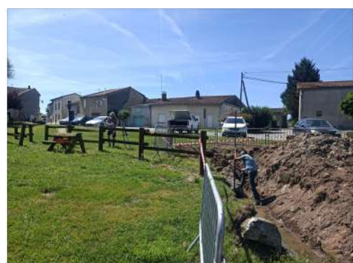
Rénovation du réseau pluvial à proximité de l'aire de jeu
