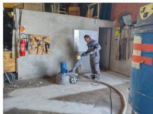
Rénovation du sol des ateliers municipaux
