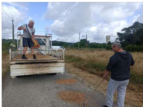
Rebouchage des trous
